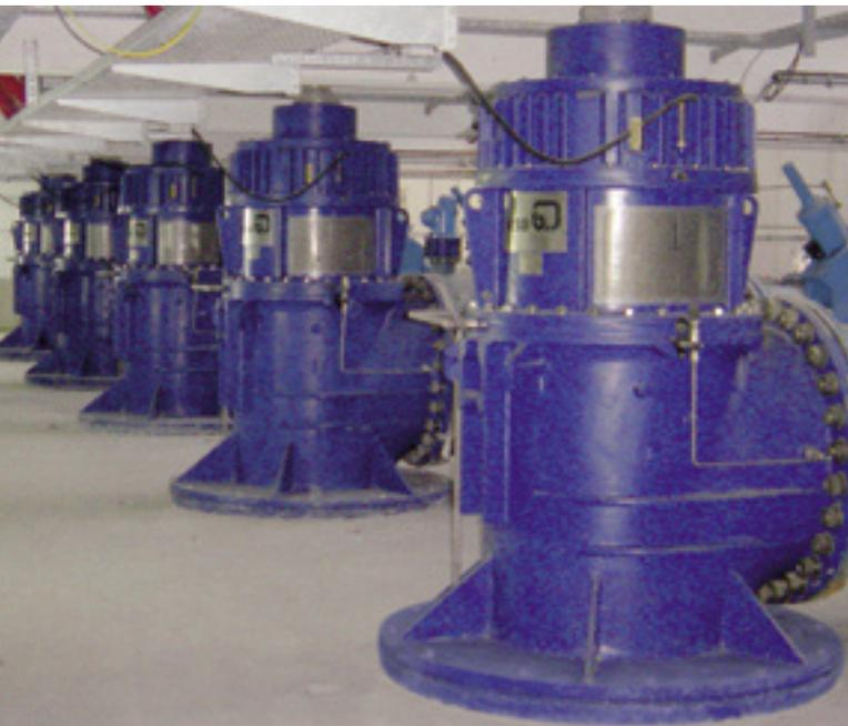
In einer neuen Pumpstation zur Trinkwasserversorgung Istanbuls fördern sechs KSB-Rohrgehäusepumpen 43.000 Kubikmeter Wasser pro Stunde.
